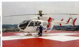
■ 屋上ヘリポート
