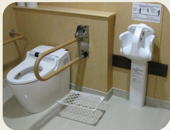
トイレ内の様子
